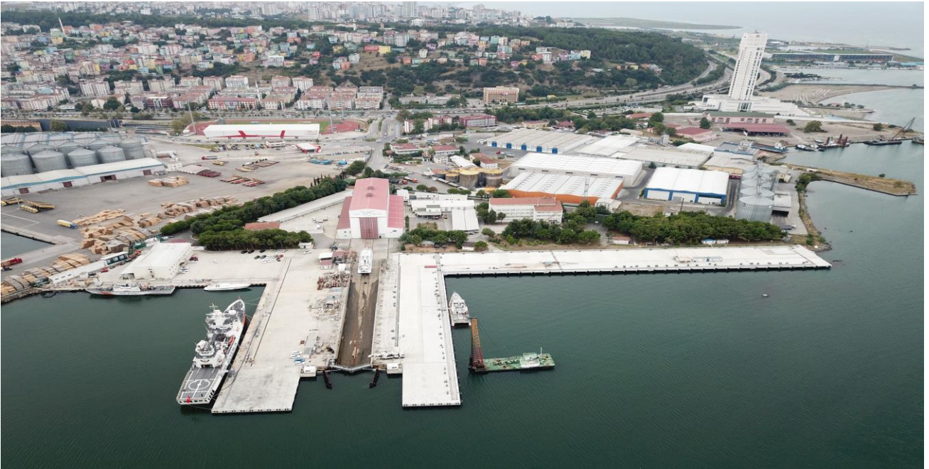
SG Karadeniz Bölge Komutanlığı Rıhtımın 30 m Uzatımı ve Güney Rıhtımın Düzenlenmesi
