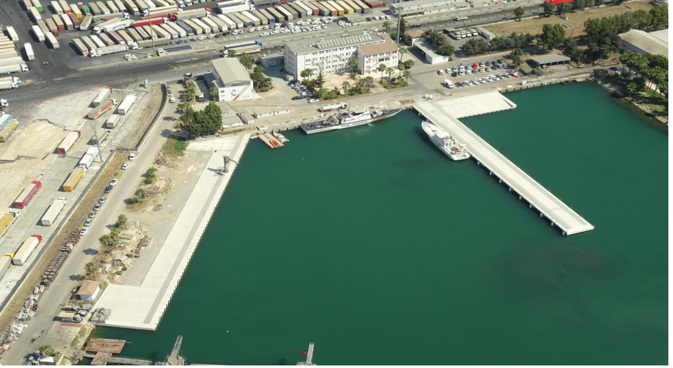
SG Akdeniz Bölge Komutanlığı Rıhtım ve İskele İnşaatı
